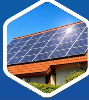
HỆ THỐNG ĐIỆN MẶT TRỜI
